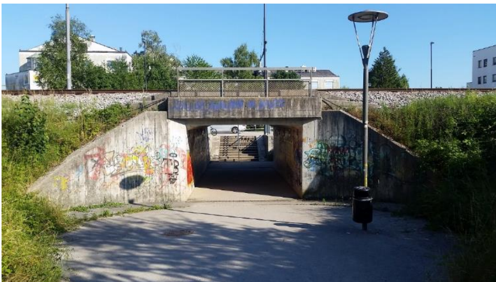
Pogled na desno stran podhoda, kjer se bo namestila nova PHO.
